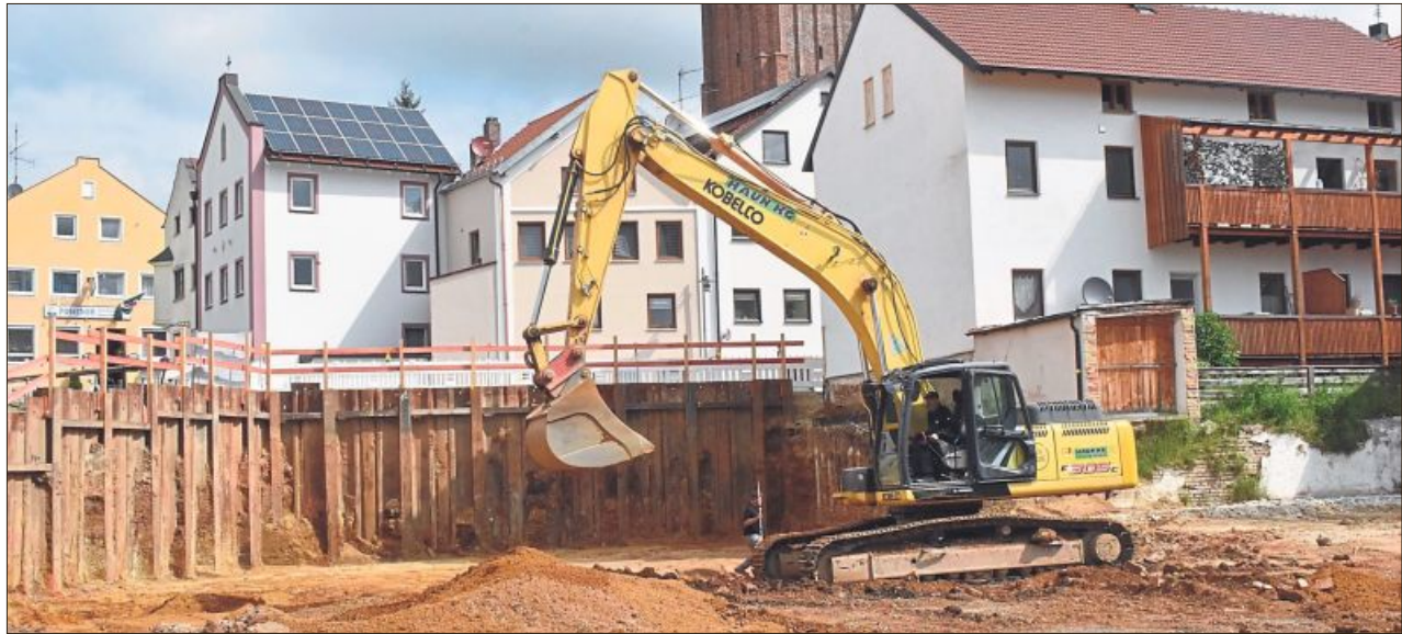
An der Baustelle hinter dem Rathaus wurden bisher weiterreichende Absicherungsmaßnahmen zur Frontenhausener Straße und zum Nachbargebäude vorgenommen.
